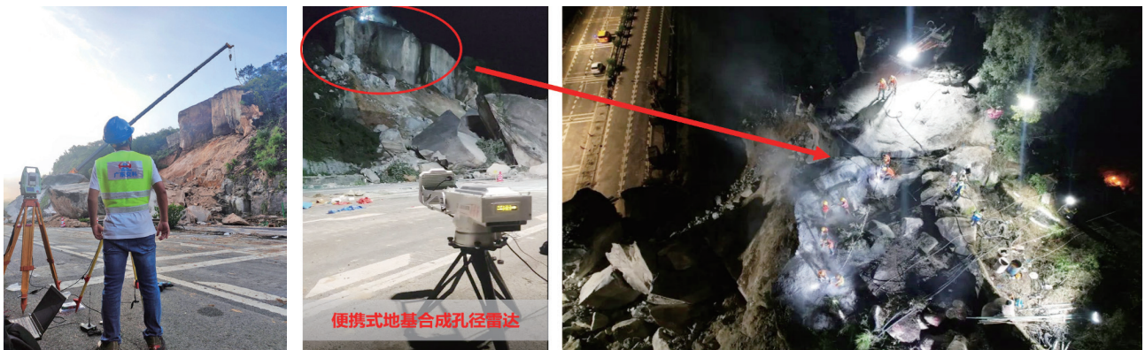
深汕东高速K2568危岩崩塌处治过程应急监测
