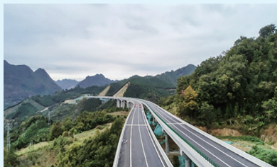
拥里1号高架特大桥
