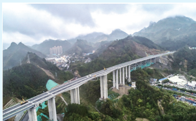
拉所2号高架大桥
